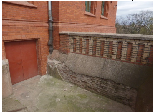
Fot.10 Wtórna zaprawa na ceglach do usunięcia
