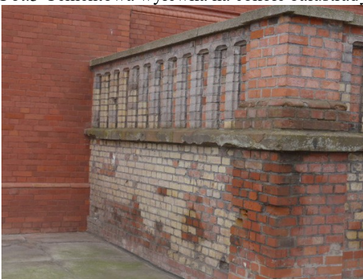
Fot.4 Fragment mokrego muru, współczesne wstawki ceglane
