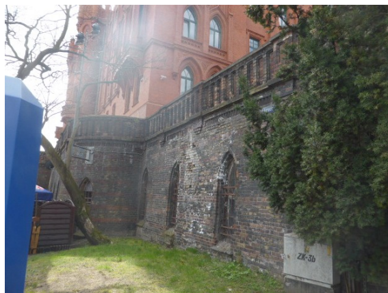
Fot.26 Drzewo z wrastającymi w mur korzeniami, silne wysolenia elewacji
