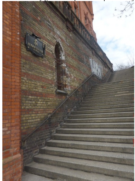
Fot.16 Silne wysolenia wokół okna ściany
