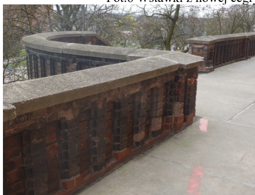
Fot.7 Widoczne cementowe wstawki kształtek ceglanych
