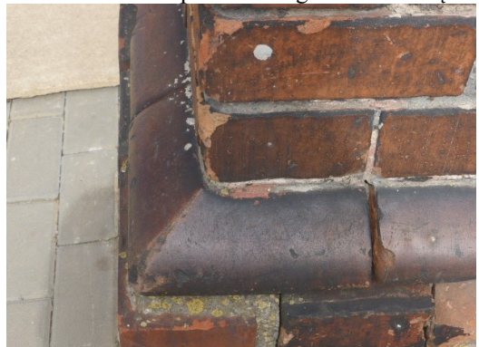
Fot.11Oryginalne kształtki gzymsu
