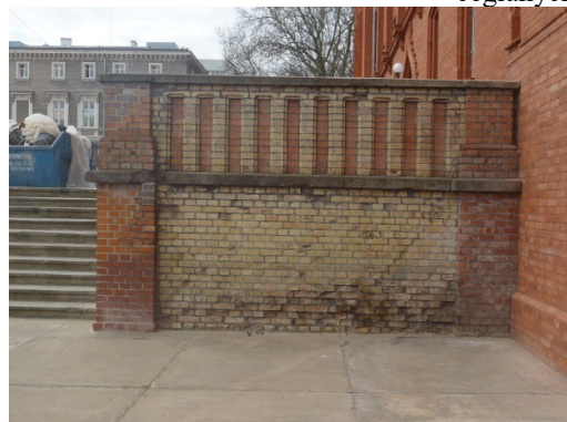
Fot.8 Ubytki muru od strony elewacji północnej
