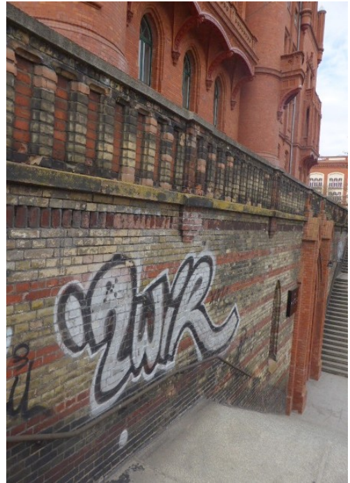
Fot.13 Ściana pionowa pod tarasem, wysolenia i napisy grafitti
