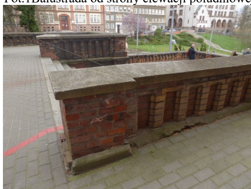
Fot.2 Balustrada przy schodach, nakrywy z lastriko
