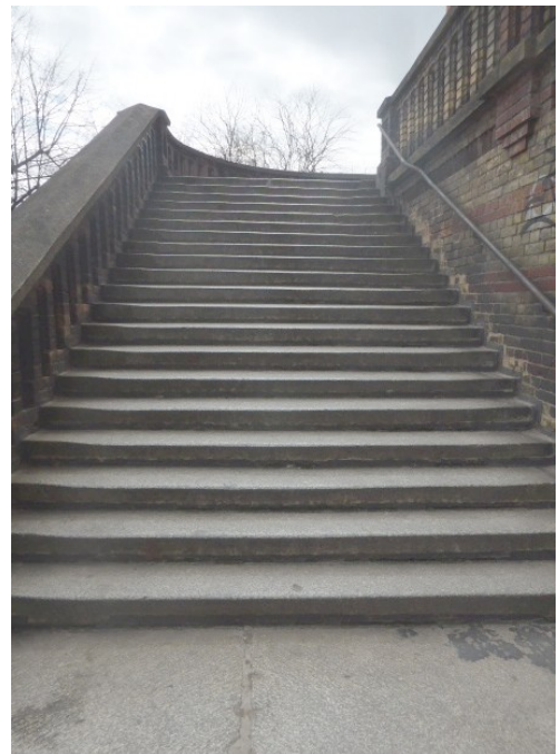
Fot.14 Schody granitowe w dobrym stanie zachowania
