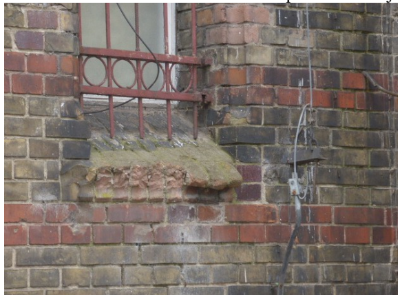
Fot.21 Cementowe kształtki parapetu
