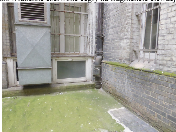
Fot.34 Betonowa posadzka tarasu do wymiany
