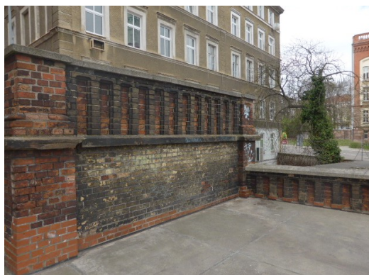
Fot.5 Silnie zanieczyszczone cegły i kształtki balustrady
