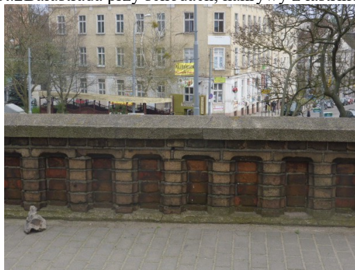
Fot.3 Cementowa wylewka na cokole balustrady
